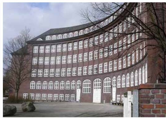
Abb. 5: Denkmalgeschütztes Gebäude (Stadtteilschule Barmbek)
