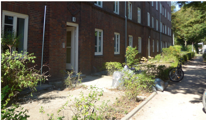
Die Wiederherstellung der Vorgärtenflächen nach Gebäudesanierungen ist ebenfalls bis zu 50% förderfähig
