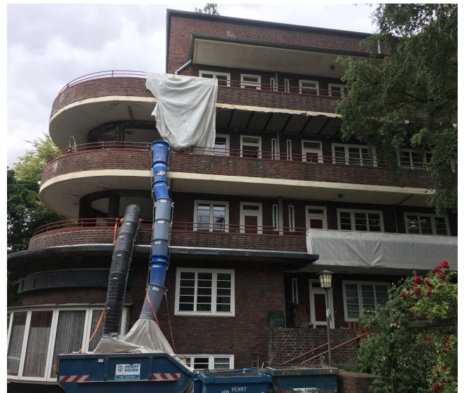
Sanierung von zwei Gebäuderiegeln der Frankschen Laubenganghäuser. Die Arbeiten sind bereits voll im Gang!
