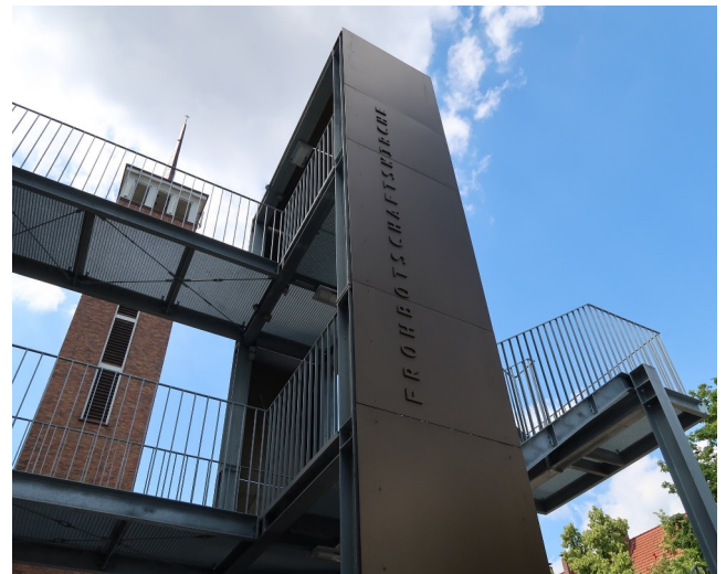
Frohbottschaftskirche Dulsberg erstrahlt in neuem Glanz; hier mit neuem Fluchtturm
