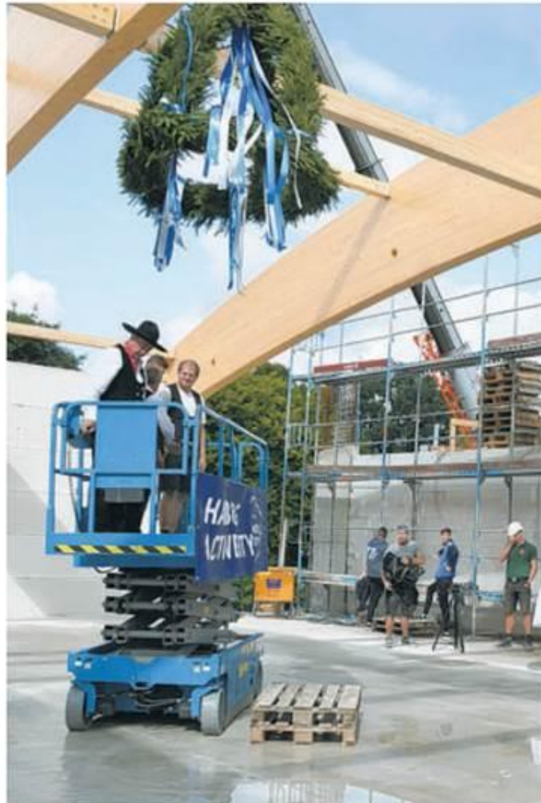
Die aufwendige Dachkonstruktion ist fertig – das musste gefeiert werden Foto: Grell
