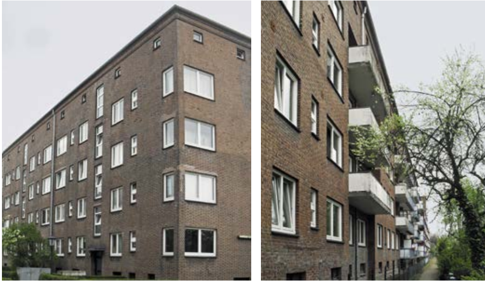
Zustand vor der Sanierung
