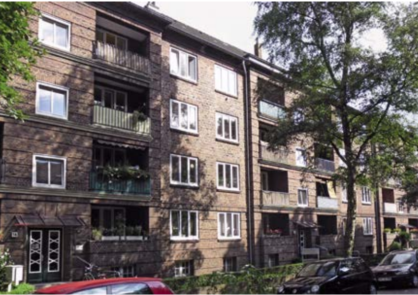
Zustand vor der Sanierung
