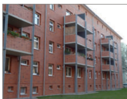
Spaltklinker/ angebaute Balkone
