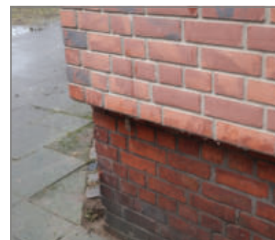
Material/ Zustand: WDVS/ Riemchen
