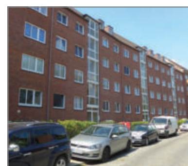
Fassade Eupener Straße
