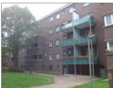
Schon vorhandene und neu aufgeständerte Balkone
