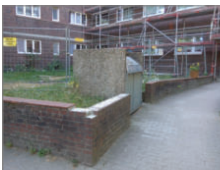
Vorgärten während der Sanierung
