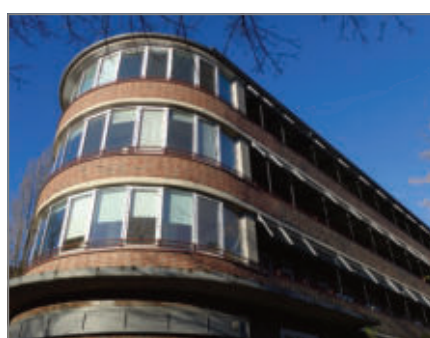
Verglaste Terrassen und Schlagregenschutz
