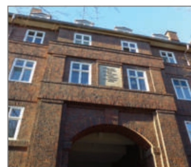
Eingangssituation mit Torbogen
