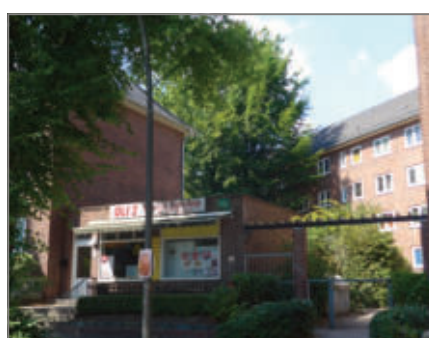
Ladeneinheit und Zugang zum Innenhof
