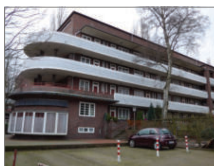
Sicherung bei Bauschäden
