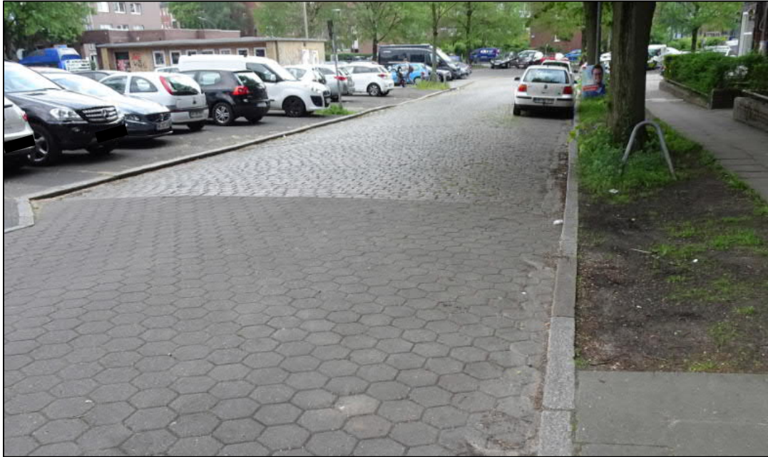
Abb. 2.4 Elsässer Platz - Südwestseite, Blick Richtung Stormarner Straße (Quelle: Sweco GmbH)
